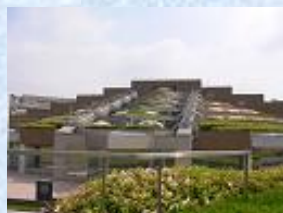
プールの裏側
